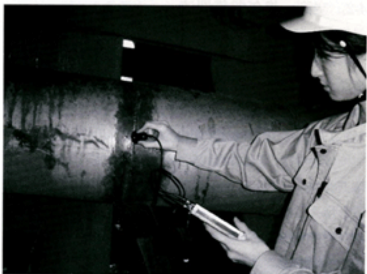
写真4 給水本管の肉厚測定状況
