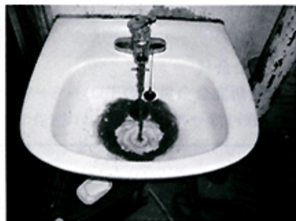
写真5 管更生後15年が経過した管のオゾン洗浄作業
