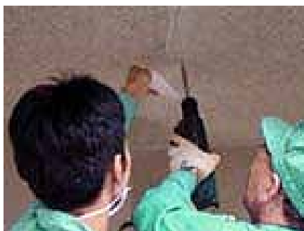
建物廊下天井の作業風景
