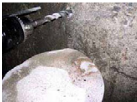
ドリルによる削りクズ採取作業
