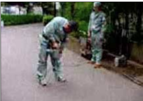
ボーリング確認（漏水箇所確認調査） 掘削後確認（地下 1.2m の埋設管に 0.2L/ 毎分の漏水発見）
