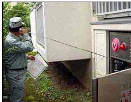
埋設管露出部での 音聴調査状況
