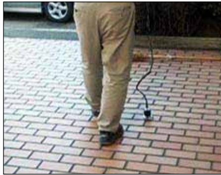
漏水探知器による 音聴調査状況
