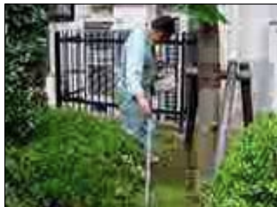
管路調査の様子
