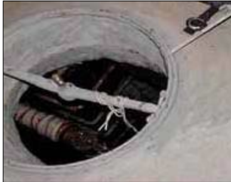
量水器での漏水量測定 受水槽の水位測定状況
