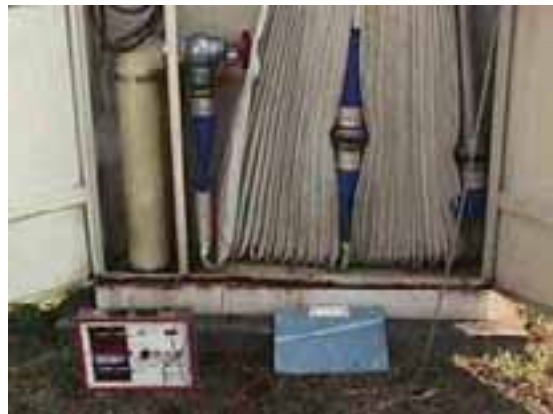
屋外消火栓に取付けた金属探知器で埋設管路を探します。
