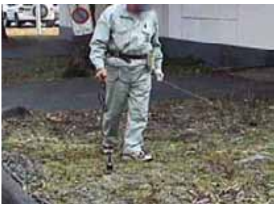
管路調査後、漏水探知器で調査
