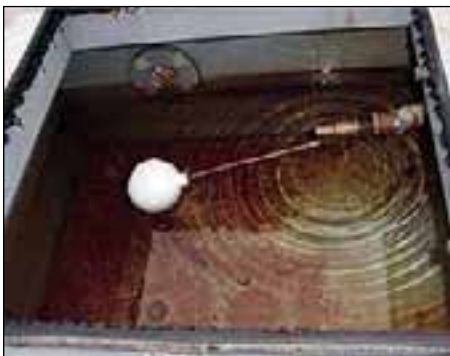
ボールタップ補給水の量から
