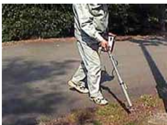
対象区画を探査し、10センチの正確さで管路を探します。
