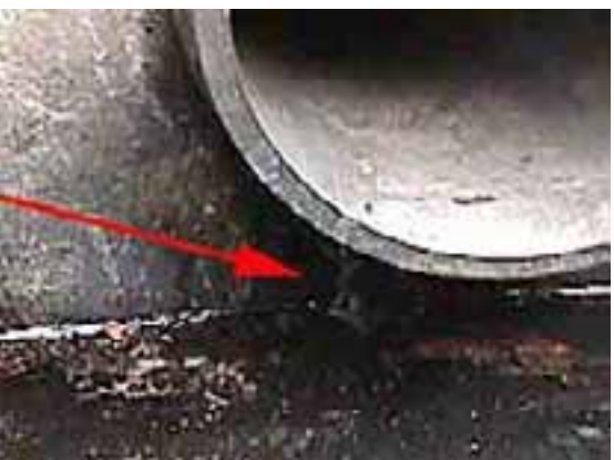
排水管を伝って外側から流れる水量は 毎分12リットルと推定。
