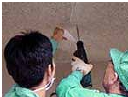
建物廊下天井の作業風景
