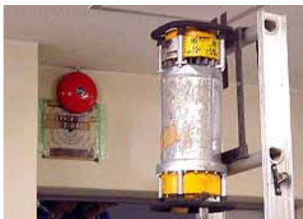
コア抜き前のX線撮影調査
